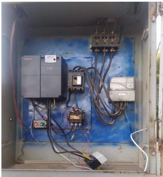
5-rasm. O'rnatilgan chastota o'zgartirgichning umumiy ko'rinishi
